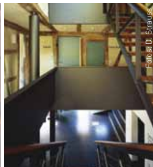
Aufgesattelte Blockkeiltreppe in der Seitenansicht (links) und der Draufsicht (Mitte) am Bindhof Metzgingen-Neuhausen. Rechts die neue Treppenhauskonstruktion
